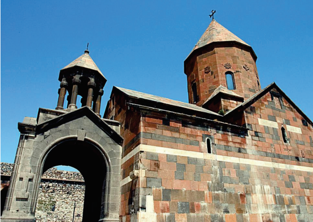
Klosteranlage Chor Virap
